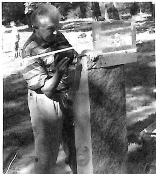
Riparazione del pilastro di Nettuno, estate 2002
