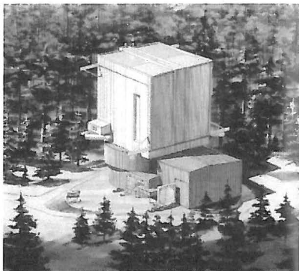
La costruzione (mobile e solidale al telescopio nella sua parte superiore) che ospita il LBT sulla cima del Monte Graham
